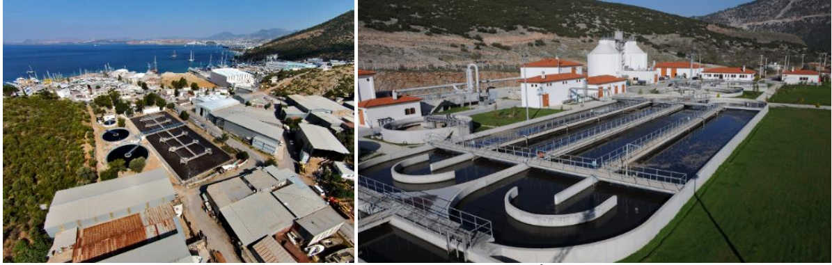
Şekil 5: Muğla Konvansiyonel Atık Su İşleme Tesisi
